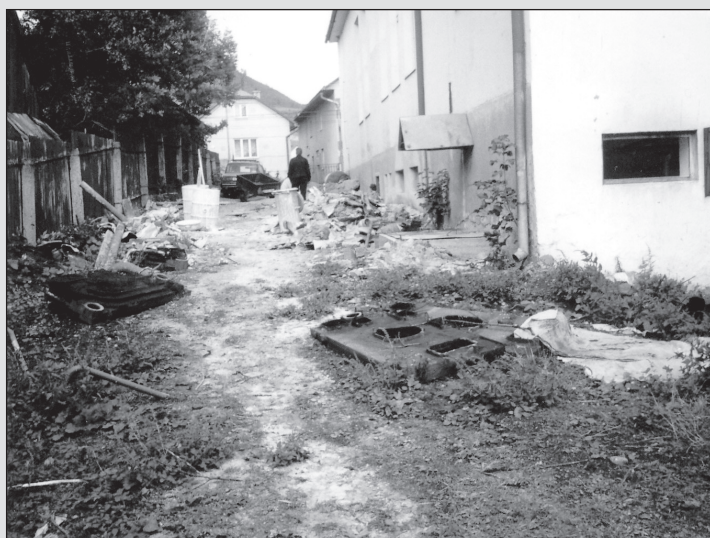
1996 – Priestor za telocvičňou (počas plynofikácie kotolne)
