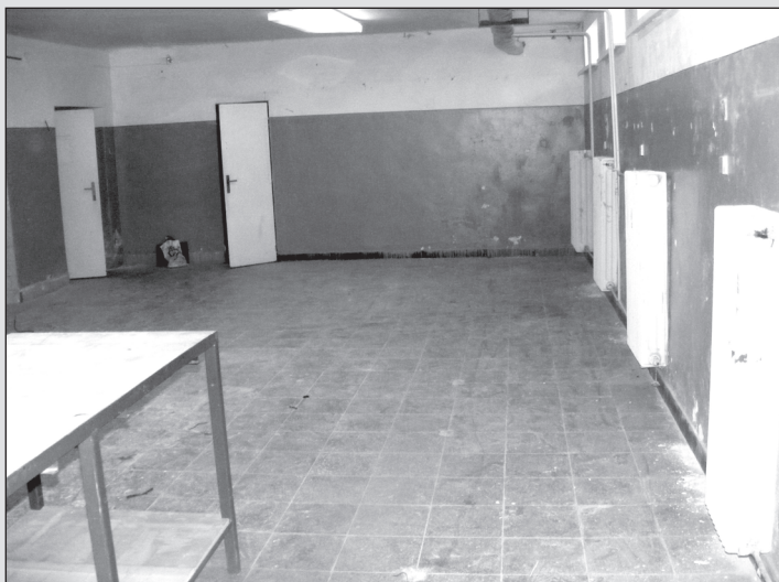
2007 – Pivničné priestory (budúca krajčírska dielňa)
