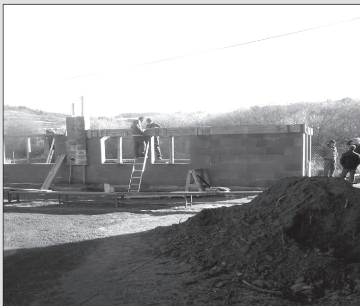
2012 – Budovanie novej dielne pre SŠ (svojpomocne na mieste bývalej budy)
