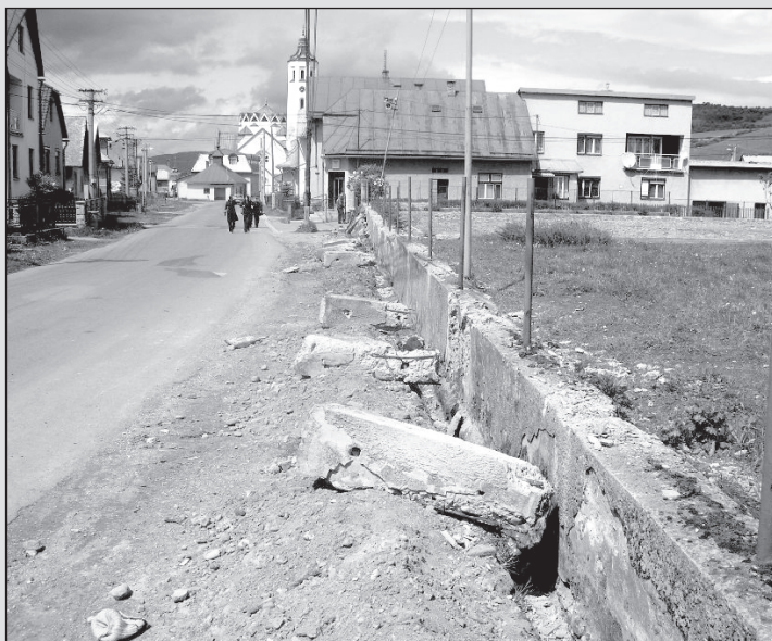
2008 – Svojpomocná oprava plota (pri hlavnej ulici) a parkoviska na mieste bývalej bytovky
