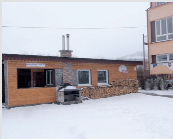
2013 – Dokončená dielňa stavebnej výroby pre SŠ (naši rómski žiaci v odbore stavebná výroba si ju vybudovali svojpomocne pod odborným vedením majstra Petra Vresiloviča)
